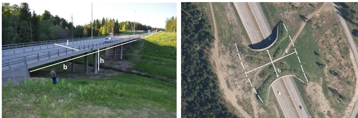
Figur 2. Angir målepunkt for bredde, høyde og lengde for en viltundergang, samt lengde og bredde for viltovergang.
