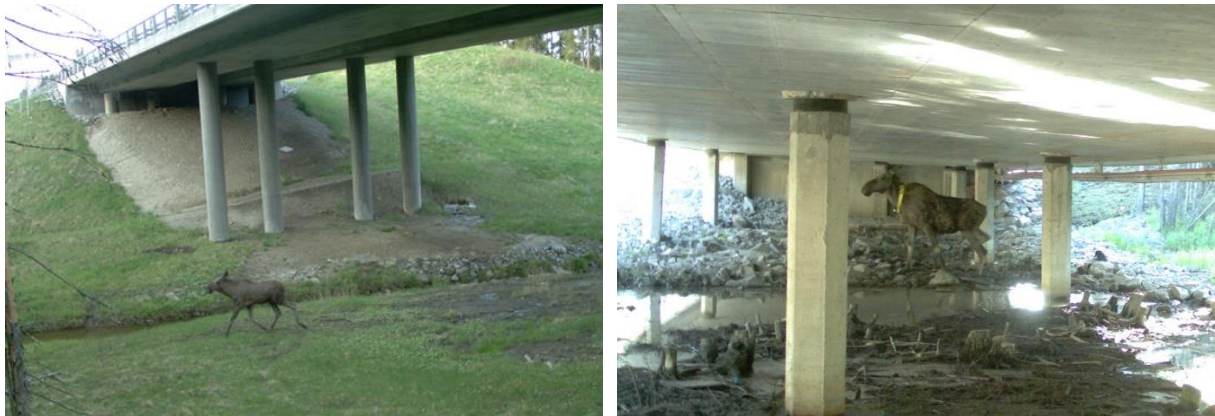
Figur 4. I regi av «Elgprosjektet i Akershus» er det vha. GPS-elg og viltkamera registrert nær 3000 passeringer av elg fordelt på mange ulike faunapassasjer. Over sees elg under brua «Lund» på E16 i Ullensaker kommune (venstre) og GPS-merka elg under lav bru ved «Klauseiemosen» på E6 i Eidsvoll kommune. Foto: Faun Naturforvaltning AS.
